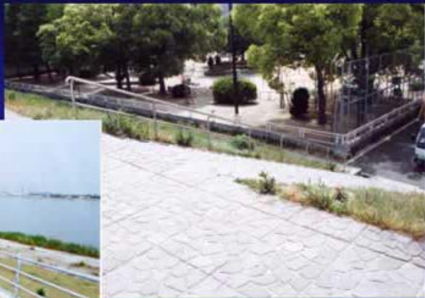
手すり付階段工
