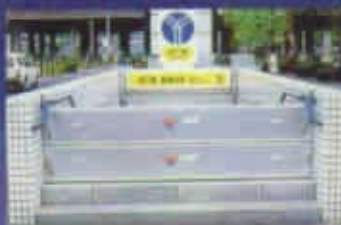
地下鉄入り口の 防水層
