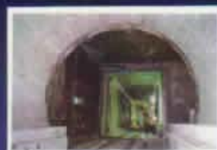
地下鉄防水層
