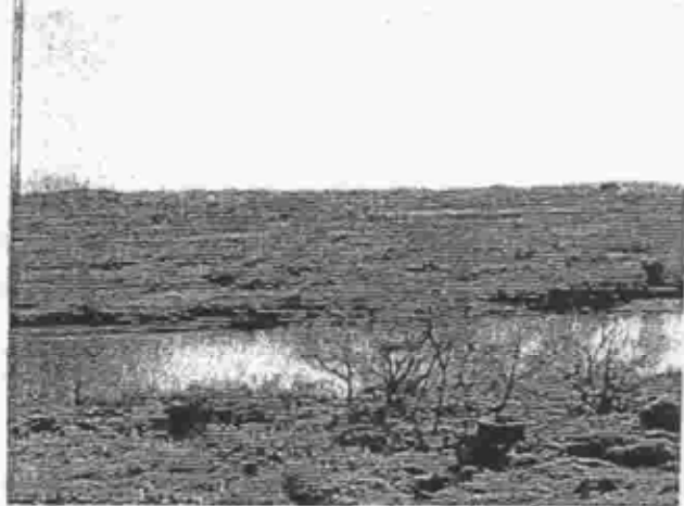
旧泉大橋(潜没橋予定地)
