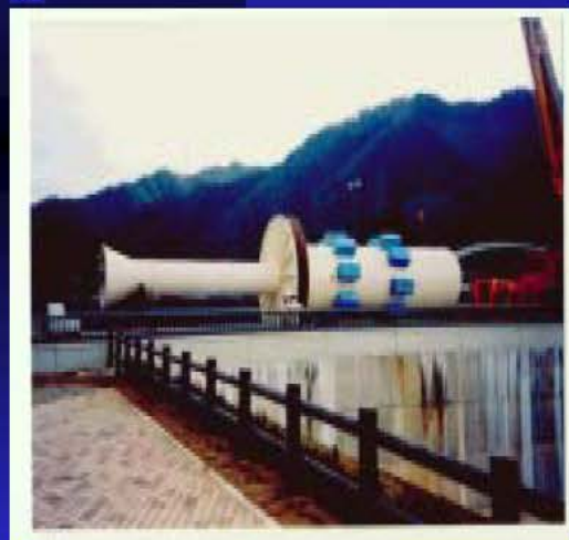
深層曝気設備 (日吉ダムの事例)
