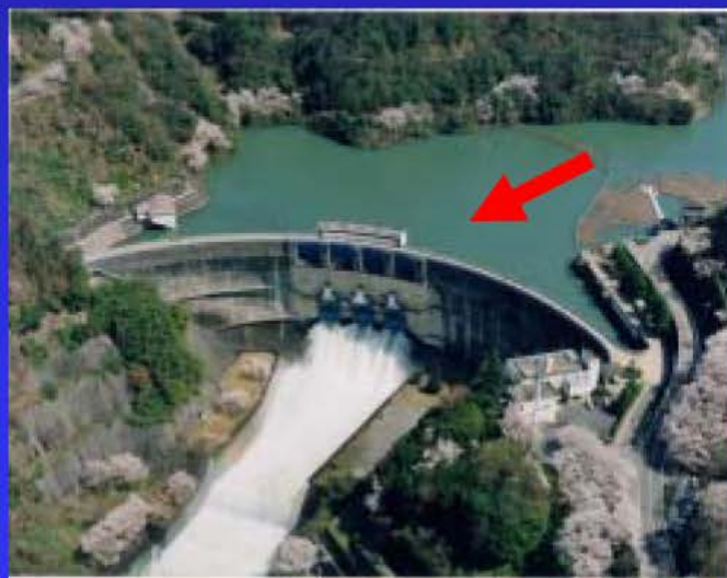
②天ヶ瀬ダム
