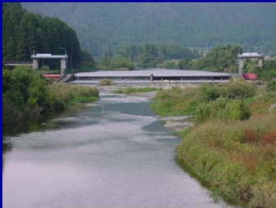
高時川頭首工(木之本町地先) (河口～約14km付近)
