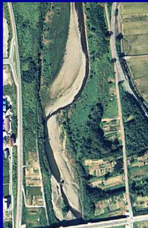
福橋付近 H13撮影 (河口～約8km付近)
