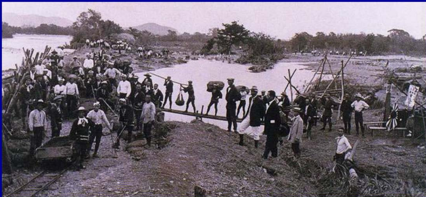
大正10年の洪水による堤防復旧工事 高月町雨森地先
