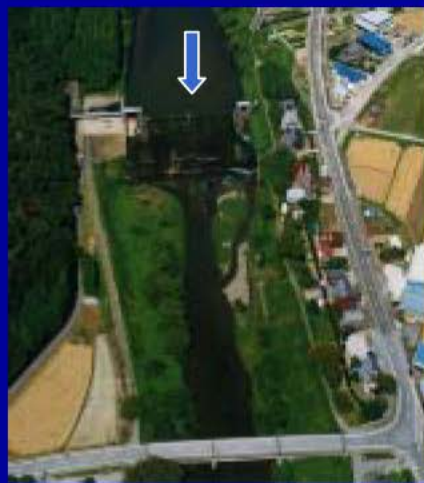
高時川頭首工 (河口より13.8km)
