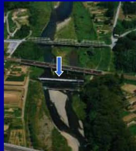
落差工(寿橋下流) (河口より9.0km) ー85
