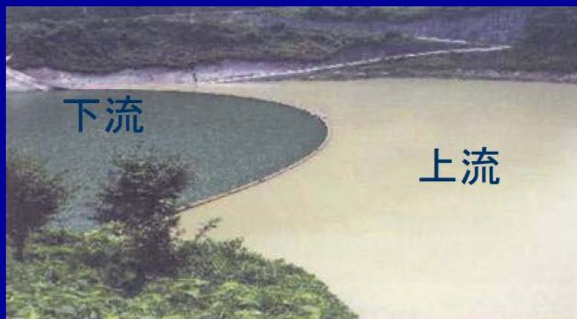
分画フェンス(濁水発生時の事例)
