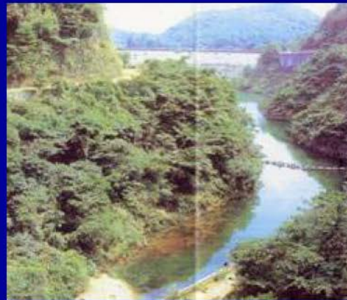
貯水池法面整備(箕面川ダム)
