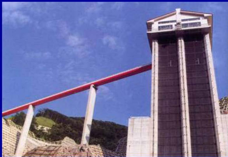
選択取水設備の例
