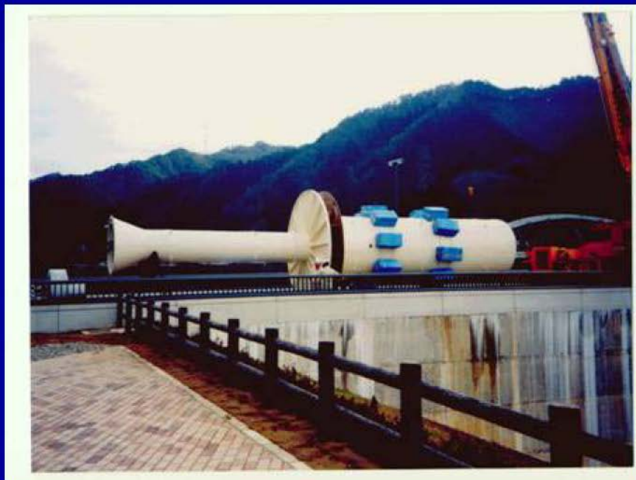
深層曝気設備の事例(設置前)
