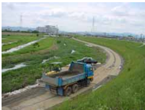
工事中道路設置後
