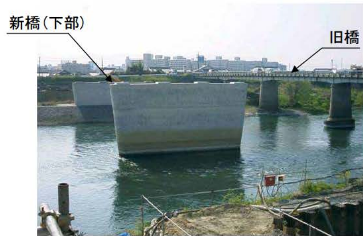
例：京都府宇治市隠元橋の架替状況
