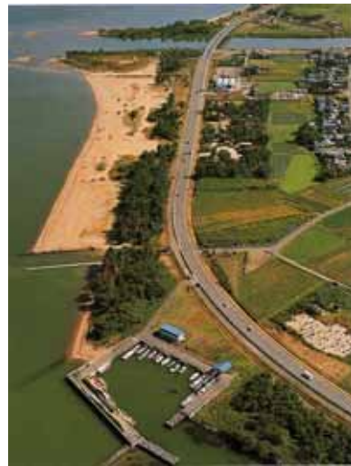
野洲川地区 湖岸堤
