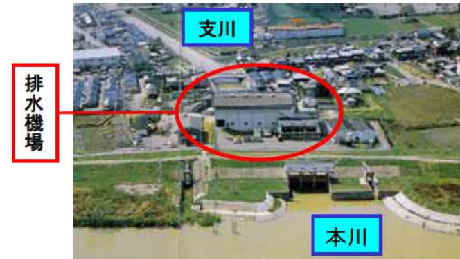
宇治川 八幡排水機場
