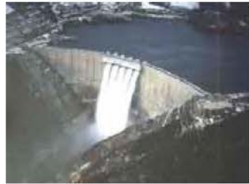
非常用洪水吐
