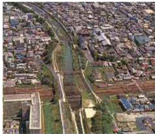
東海道本線の上を交差する草津川
