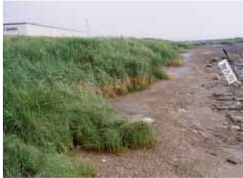
加古川の事例 工事区域内のヨシを一時仮移植し、工事完了後に再移植した。
