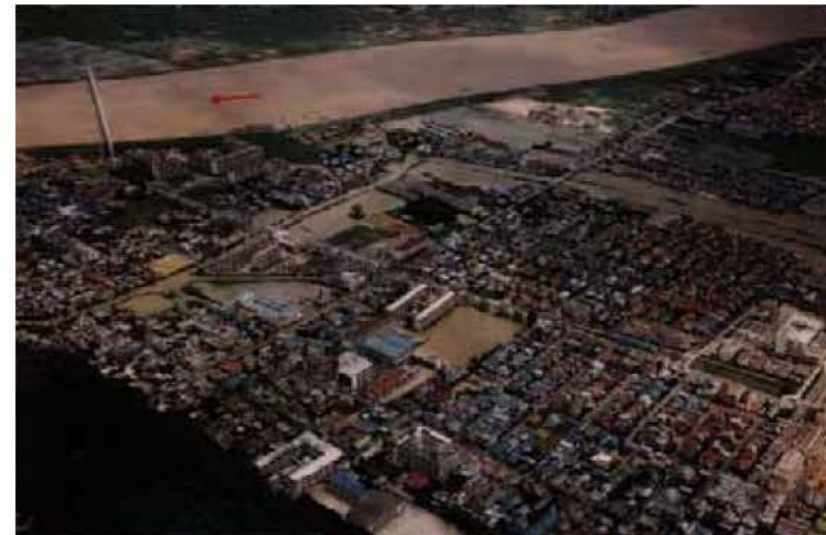
昭和57年8月（台風10号）八幡市浸水全景
