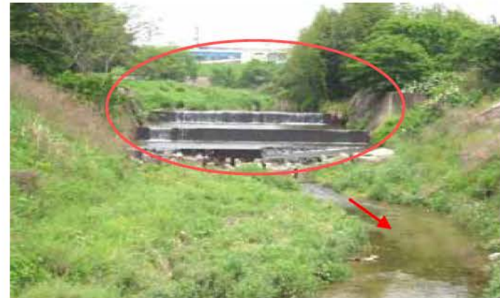
小泉川の堰の落差工
