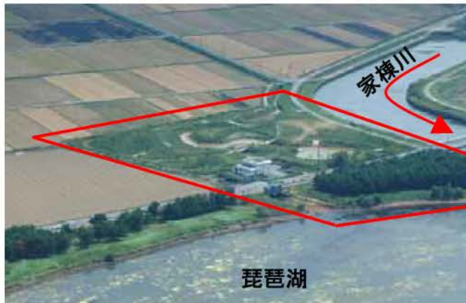
●現況写真 家棟川ビオトープ
