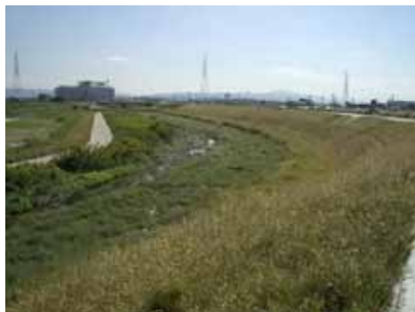
工事中道路設置前
