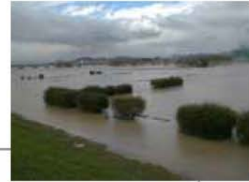
高水敷の冠水状況
