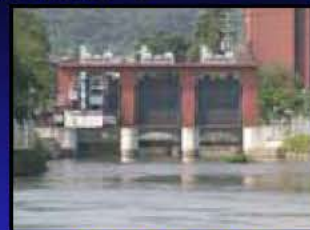
宇治発電所取水口
