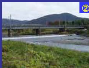
② JR北陸本線直下の床固め工H15.11.12 河川流量減少により遡上が容易でない。
