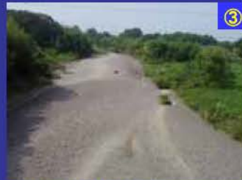
馬渡橋下流H15. 9. 19 、高時川は瀬切れ発生。
