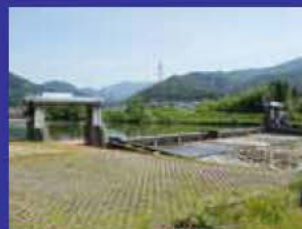
写真 高時川頭首工 (H15.6.3)
