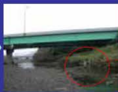
② JR北陸本線直下の床固め工H15.11.12 河川流量減少により遡上が容易でない。
