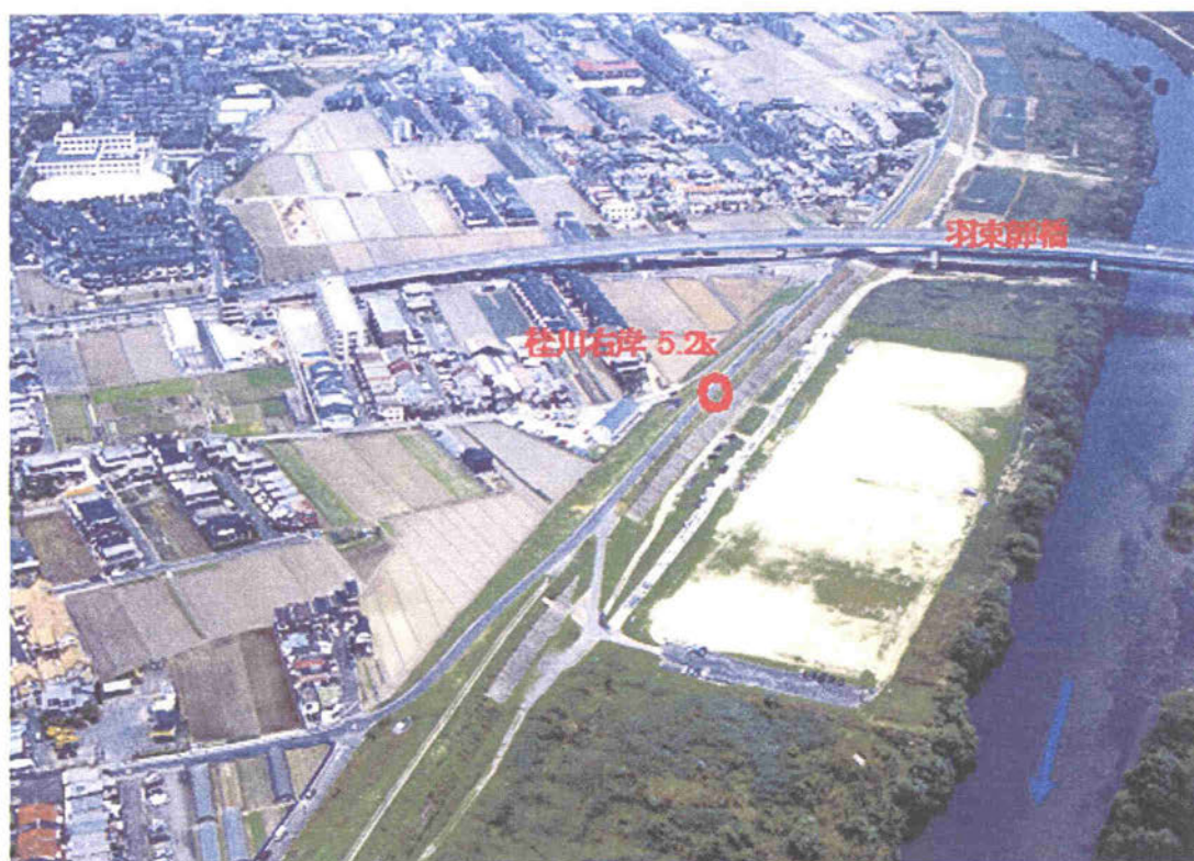
桂川右岸 5.2k 付近の状況
