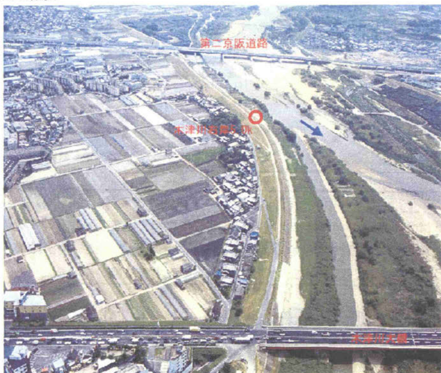
木津川右岸 5.0k 付近の状況
