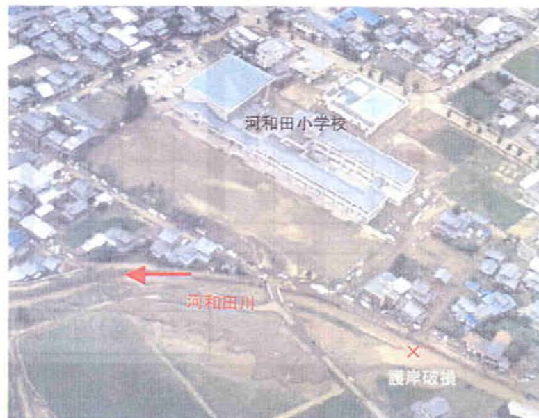
河和田川が越水し、堤内地を流下 鯖江市河和田町上空（19日撮影）
