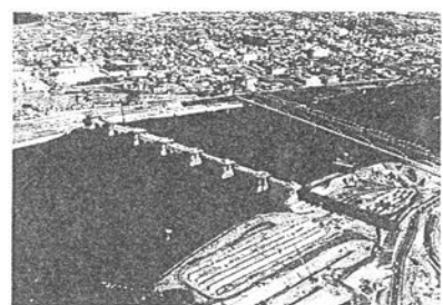
紀の川大堰(建設中)
