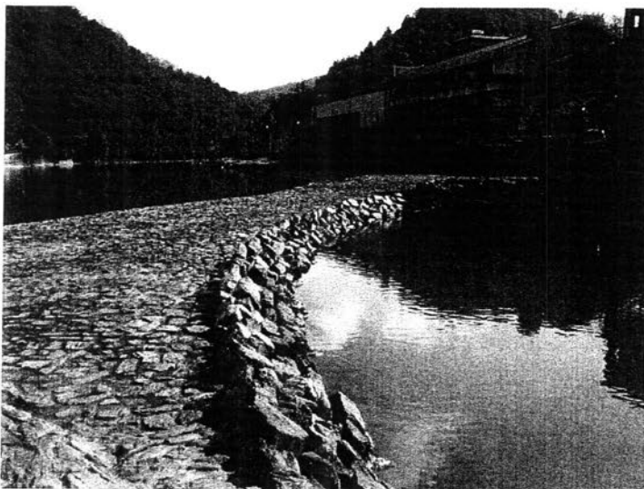
締切堤 建設費用2億円
