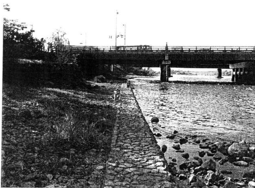
宇治川を埋め立てた塔の川床止め工事場所から宇治橋を見る
