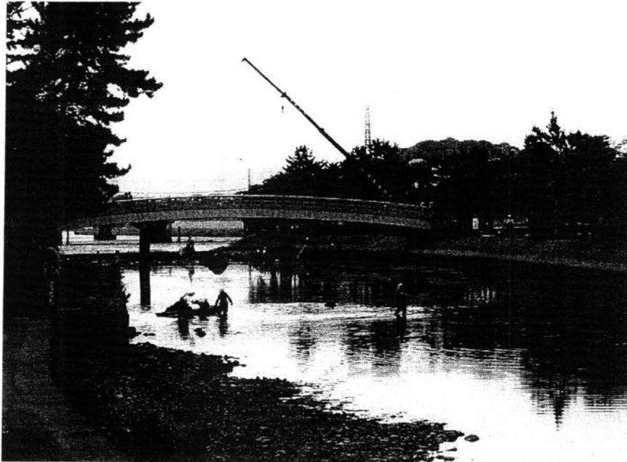
塔の川、繁茂した藻の撤去作業、年2回費用約500万円。
