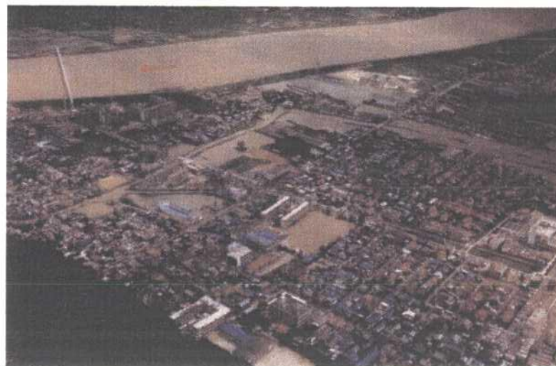
昭和57年8月（台風10号）八幡市浸水全景
