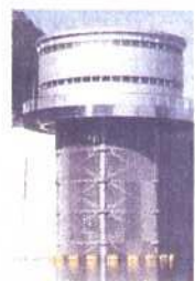
選択取水設備
