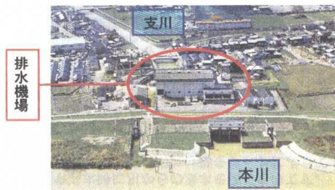
宇治川 八幡排水機場
