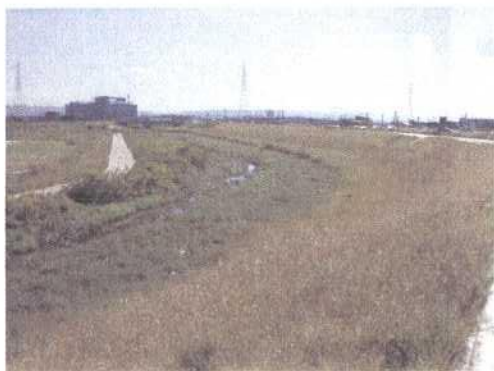
工事用道路設置前
