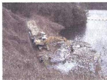
流木の引き上げ状況
