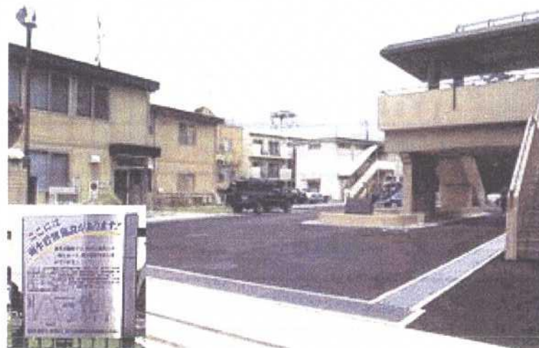
猪名川河川事務所駐車場
