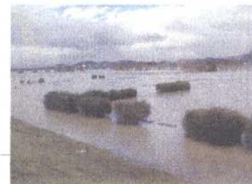
高水敷の冠水状況
