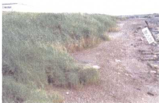
加古川の事例 工事区域内の ヨシを一時仮 移植し、工事 完了後に再移 植した。
