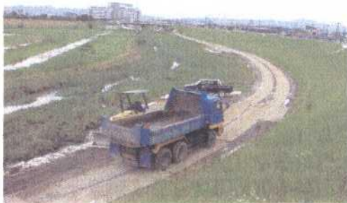
工事用道路設置後
