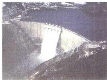
非常用洪水吐
