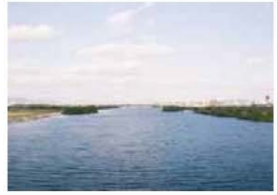
写真 1 4 3 鳥飼仁和寺大橋から上流を望む (大阪府 摂津市) 出典)大阪府
