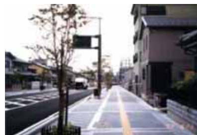
＜透水性舗装の歩道＞
