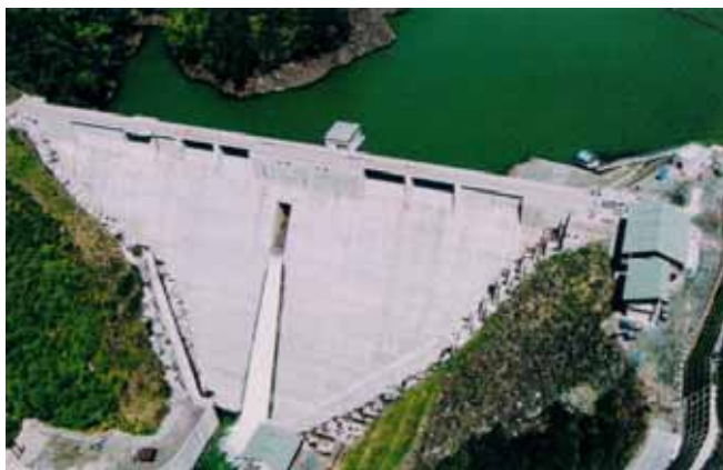
図1 姉川ダム(「月間ダム日本」2002年10月号より)
