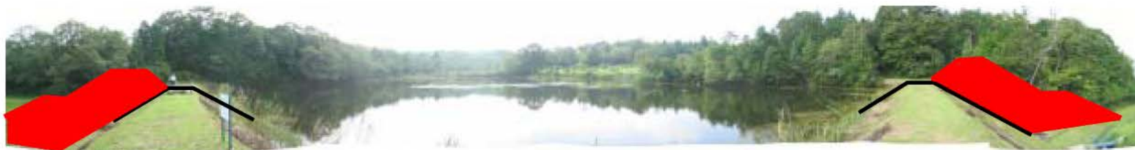
【ため池状況写真】
