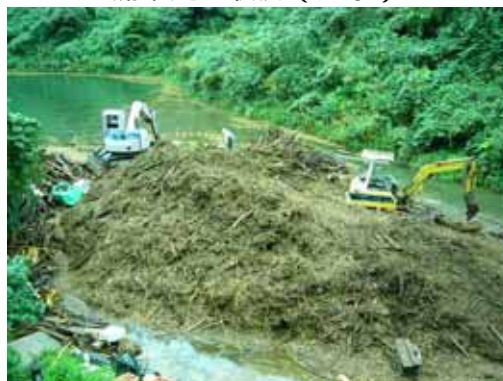
流木処理状況（遠景）
