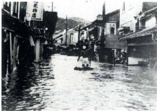
昭和28年9月 台風13号 京都府船井郡八木町 桂川の増水による旧国道9号本町3丁目あたりの浸水状況
