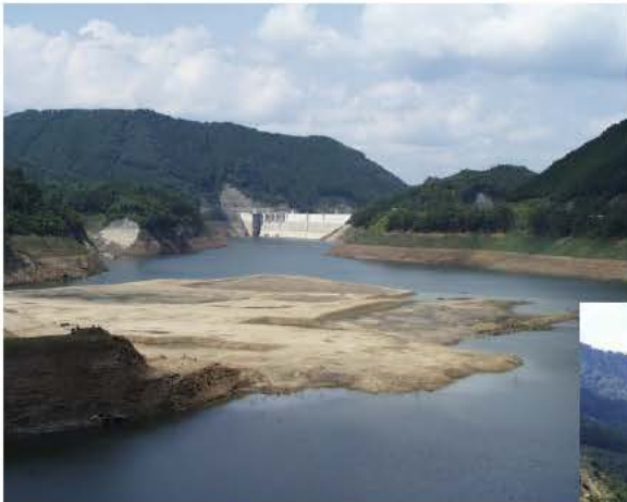
ダム上流から堤体
