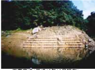
工事完成(平成12年10月現在)
