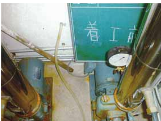
図 1.3.1-8 給水設備給水ポンプ更新(平成 17 年度)
