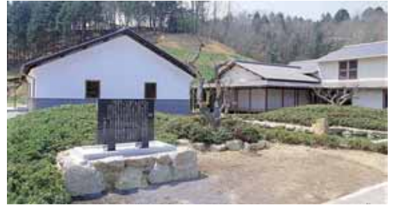
ロマントピア月ヶ瀬(月ヶ瀬村)
