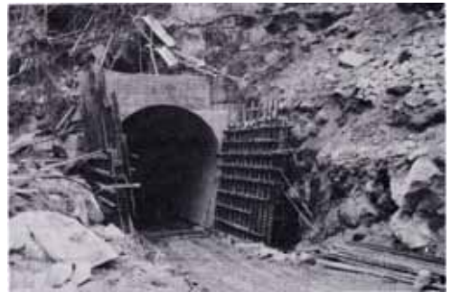
仮排水トンネル工事
