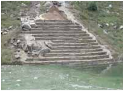
工事完成間近(平成13年10月現在)
