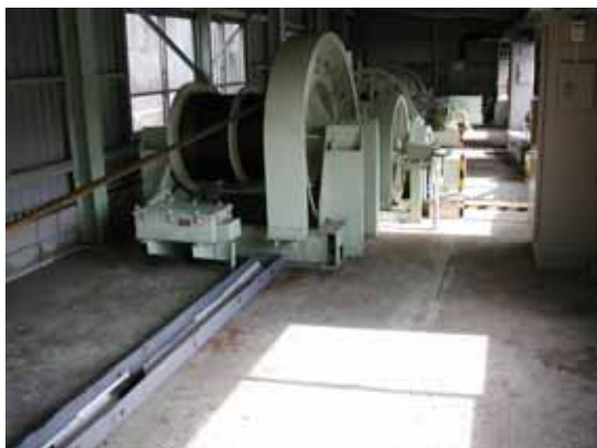
図 1.3.1-7 非常用洪水吐クレストゲート開閉装置外塗装(平成 17 年度)
