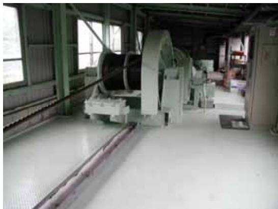
図 1.3.1-7 非常用洪水吐クレストゲート開閉装置外塗装(平成 17 年度)
