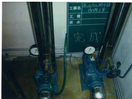
図 1.3.1-8 給水設備給水ポンプ更新(平成 17 年度)
