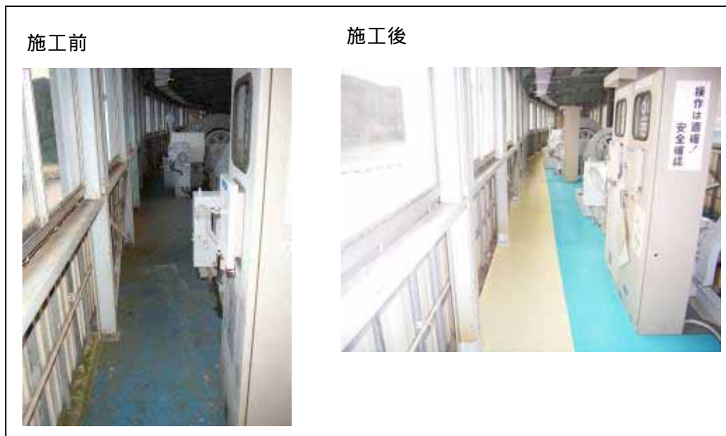
図 1.3.1-2 非常用洪水吐設備開閉機室床板整備
