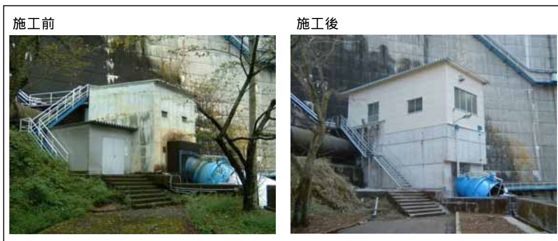
図 1.3.1-1 低水管理用放流設備建屋改修（平成 15 年度）
