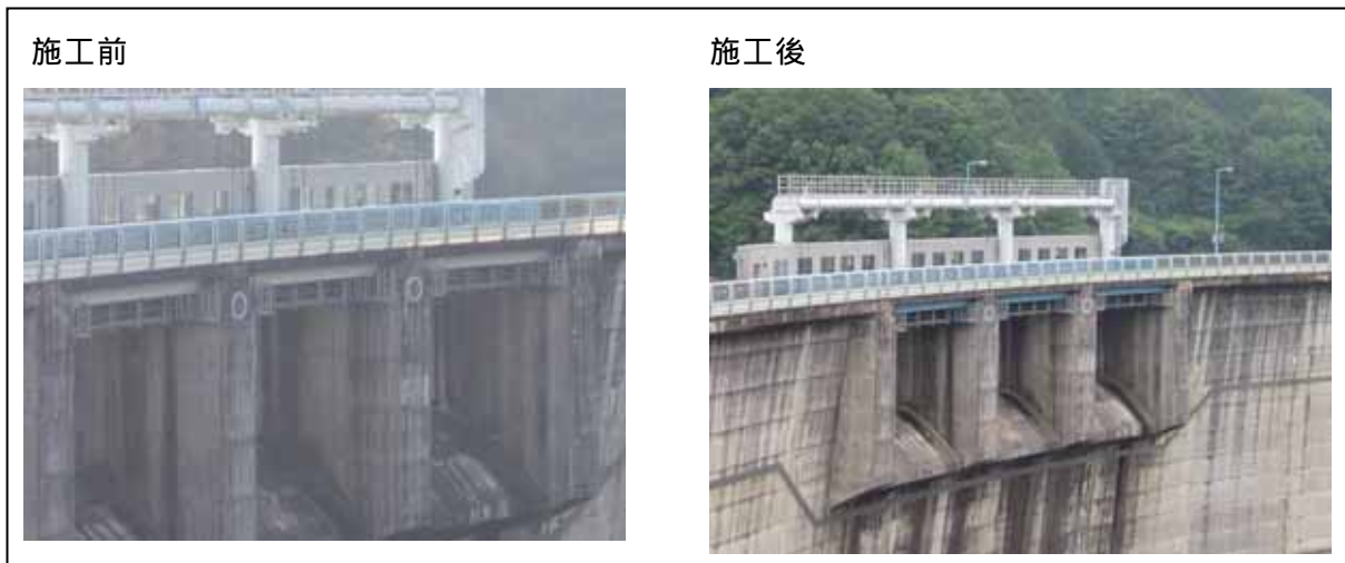
図 1.3.1-4 青蓮寺ダム堤頂橋梁外塗装工事（堤頂橋梁）(平成 17 年度)
