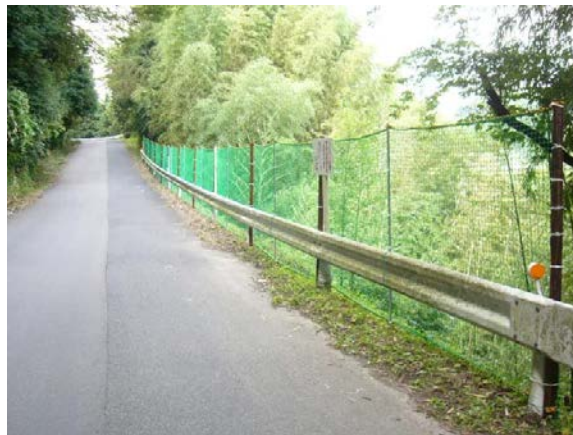
不法投棄が多い箇所に柵を設置
