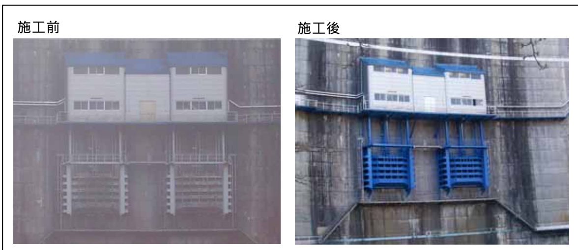
図 1.3.1-5 青蓮寺ダム放流設備整備工事（平成 17 年度）
