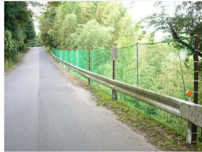
不法投棄が多い箇所に柵を設置
