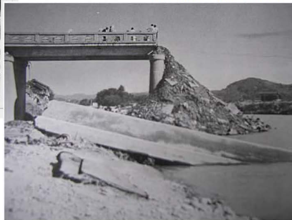
新町橋の被災状況
