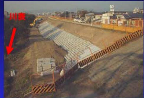
堤防にドレーン工(排水工)を設置
