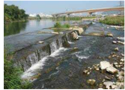
写真4.2-13久代北台井堰（猪名川）
