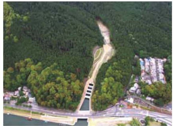
写真 4.3.3-6 大津放水路(瀬田川合流部)
