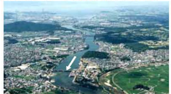
写真 2-3 瀬田川 (瀬田唐橋～瀬田川洗堰付近)
