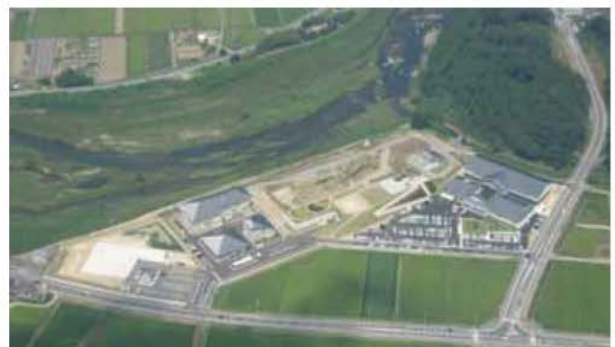
写真4.3.1-3 名張川河川防災ステーション
