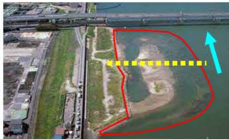
写真 4.2-3 干潟再生 (海老江地区の事例)
