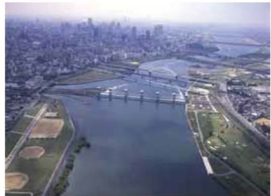
写真 3.2.3-1 淀川大堰から下流を望む
