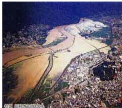
写真3.3.1-3 亀岡市街上空から (昭和57年8月台風10号)
