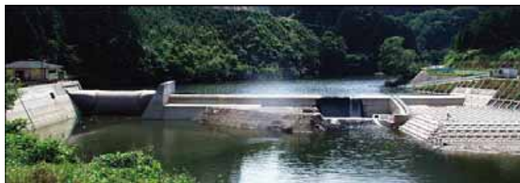
写真 4.2.4-4 副ダム (室生ダム)
