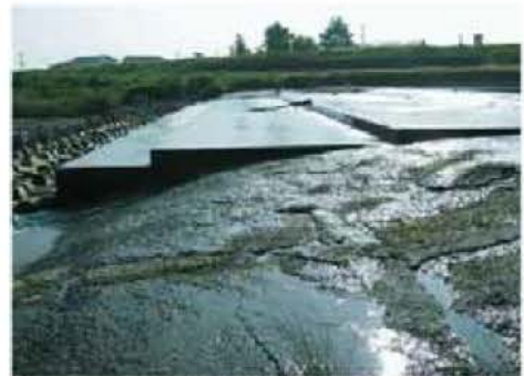
写真 3.2.1-1 魚類等の遡上阻害となっている横断工作物(高木井堰(猪名川))
