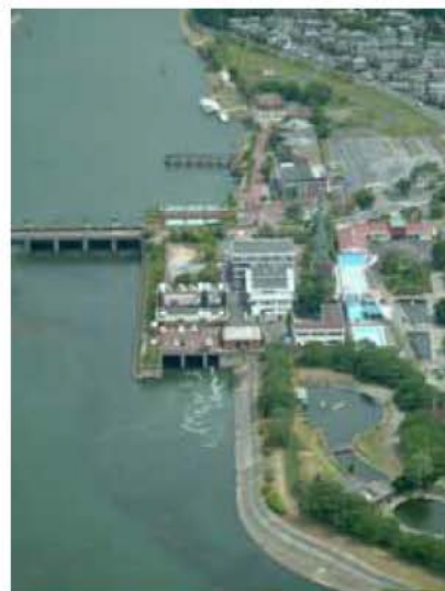
写真 4.3.3-3 瀬田川洗堰のバイパス水路
