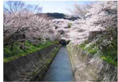
写真 2-10 琵琶湖疏水の取水口 (大津側)
