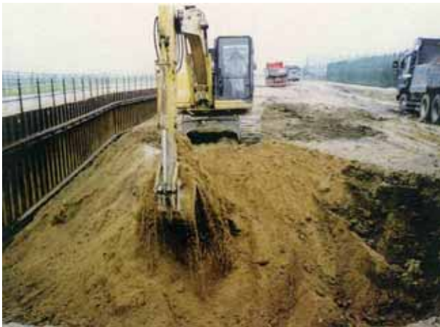
写真 3.3.1-9 木津川の堤防の状況
