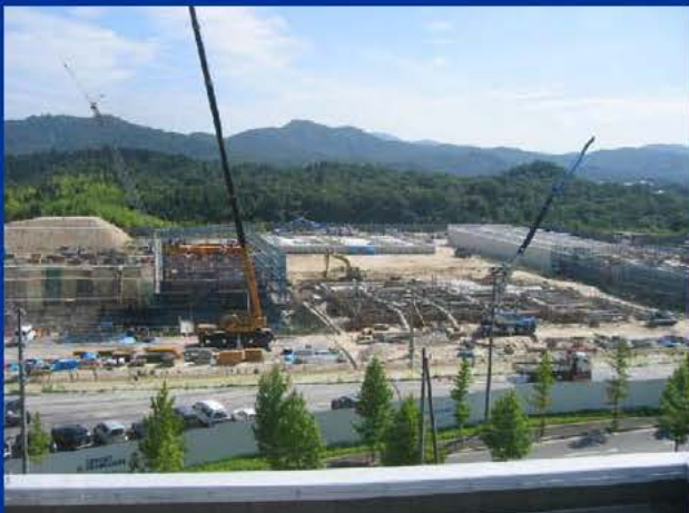
ゆめが丘浄水場の工事状況(H19年8月 現在)
