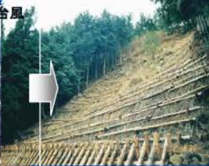
青蓮寺川山腹工
