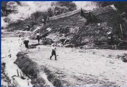
溪流の埋没による被災状況
