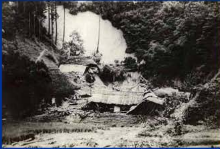
山崩れによる倒壊家屋
