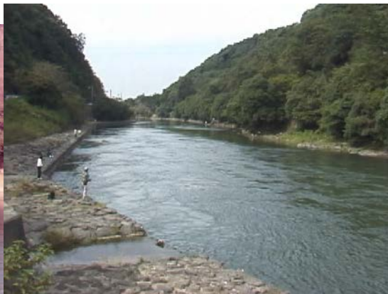
白川浜下流改修後
