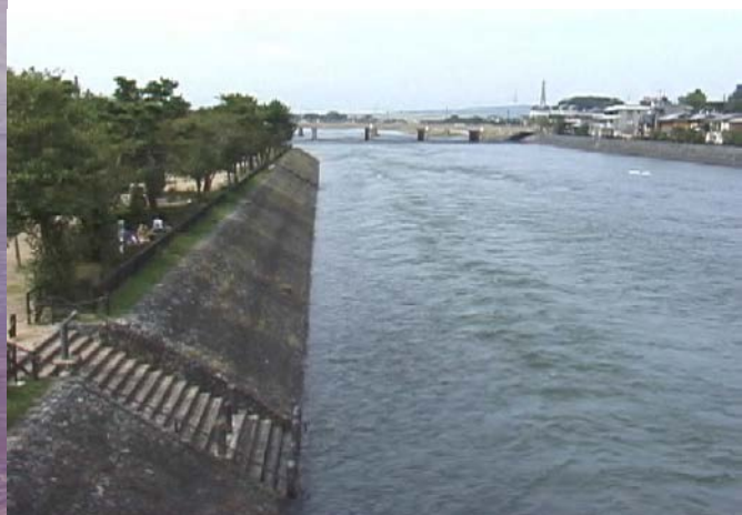
護岸工事後 朝霧橋から下流、橘島護岸
