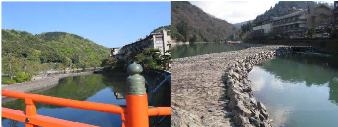
左：喜撰橋から上流の塔の川締切堤
