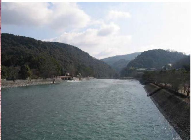
護岸工事後 朝霧橋から上流を見る
