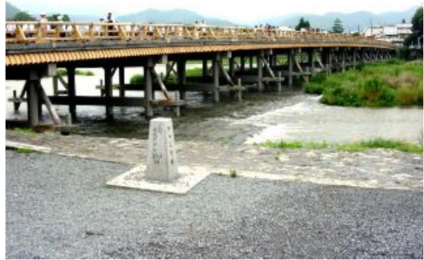
桂川右岸から見た渡月橋
