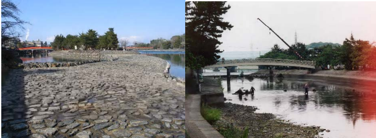
左：塔の川締切堤
