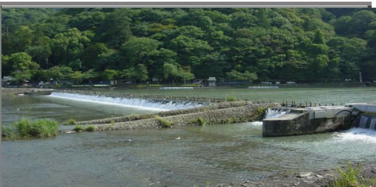
桂川左岸から見た葛野大堰
