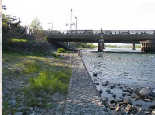
護岸工事（埋め立て）で砂州消滅
