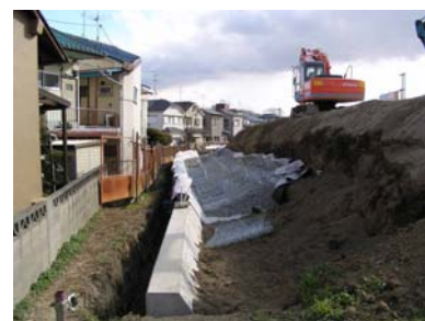
堤防の補強工事(H17年度)
