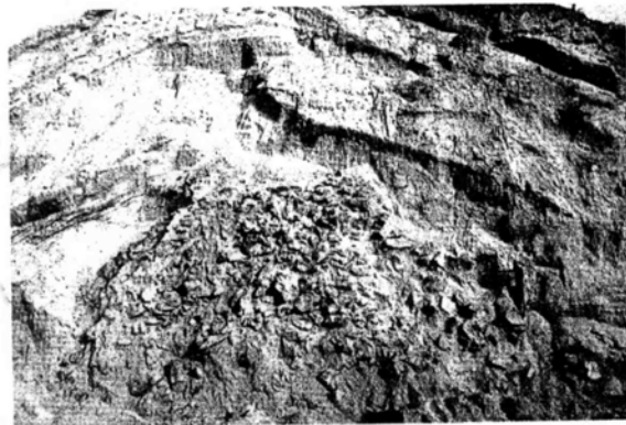
現在の左岸堤防の中に埋没している横島堤遺跡 (石の部分、昭和 54 年)
