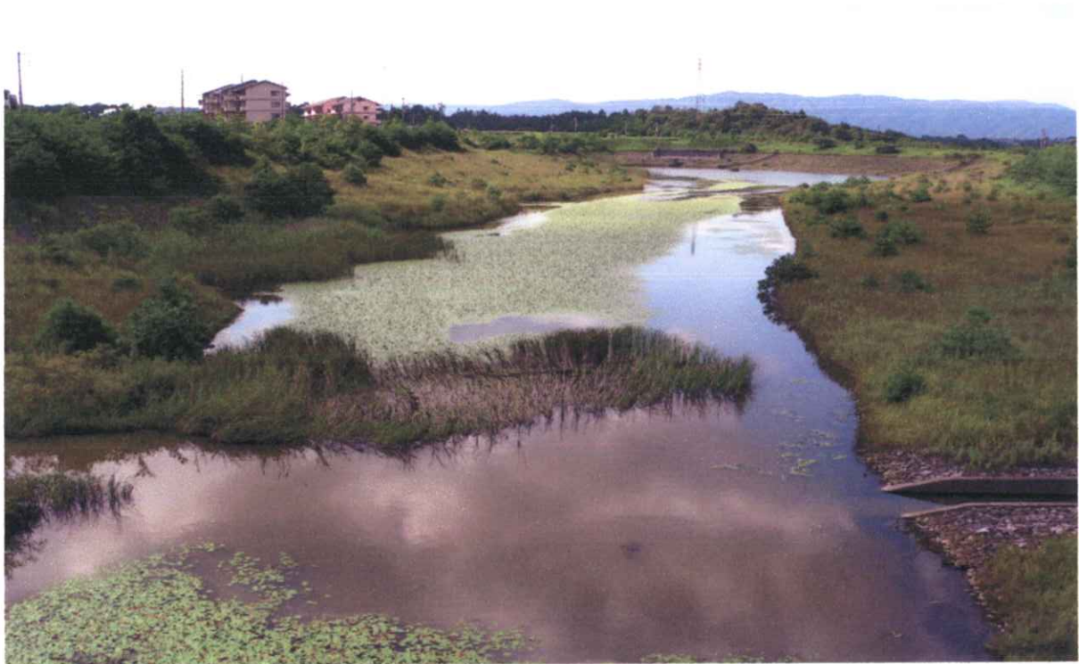
ゆめぼりす伊賀 A・つどい橋から防災調整池
