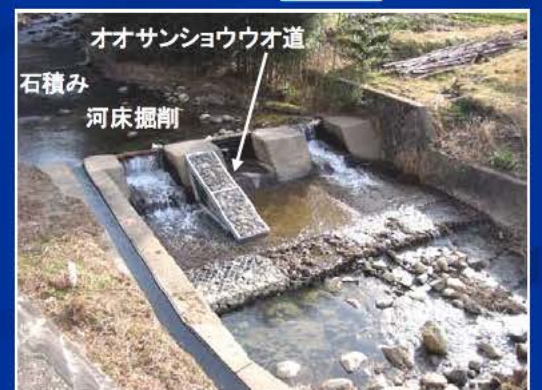
オオサンショウウオ道の設置状況(整備直後)
