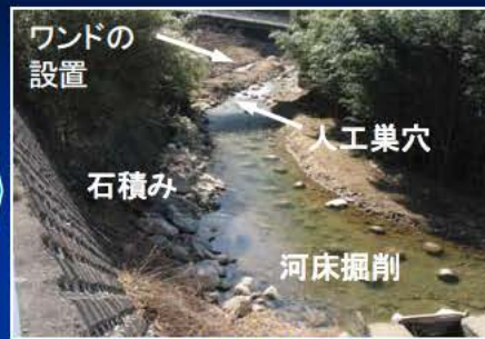
生息環境整備後の状況(整備直後)
