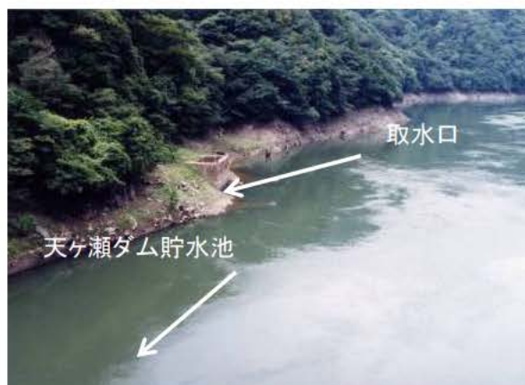
写真一補 1 旧志津川発電所導水路取水口 (貯水位 O.P.+71m 付近)
