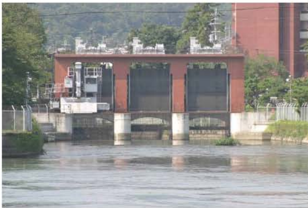
写真一補 3 宇治発電所取水口 (約 40m 3 /S 取水時)
