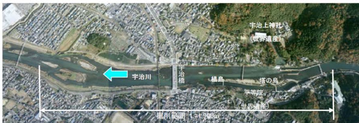
写真-4 宇治川塔の島地区の掘削範囲
