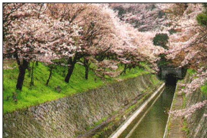
写真一補 4 琵琶湖疏水
