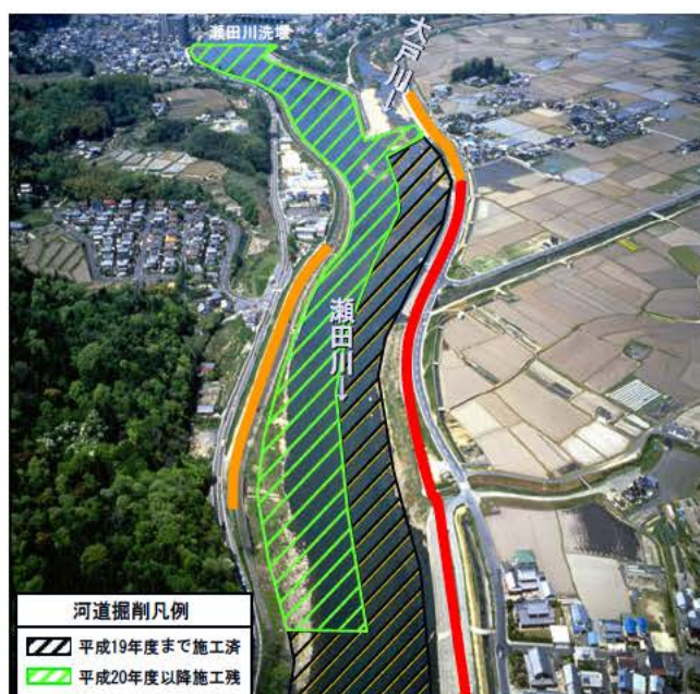
写真-2 瀬田川洗堰下流部の河道掘削
