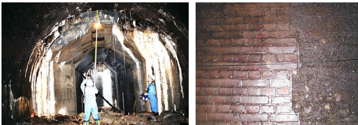
写真一補2 旧志津川導水路内の状況
