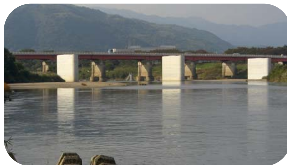
写真 3-7. 京阪電鉄鉄橋より下流の御幸橋を望む
