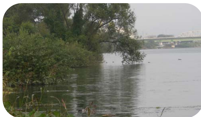
写真3-2. 一の井堰上流を望む
