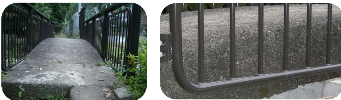
写真 3-6. コンクリートの表面
