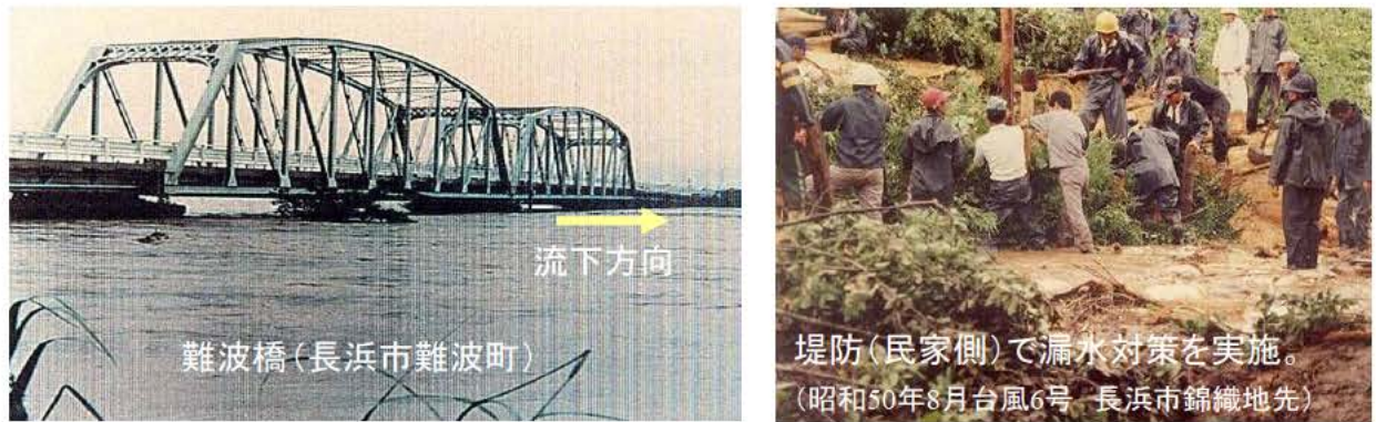
写真 2.1 昭和 50 年 8 月 台風 6 号の出水
