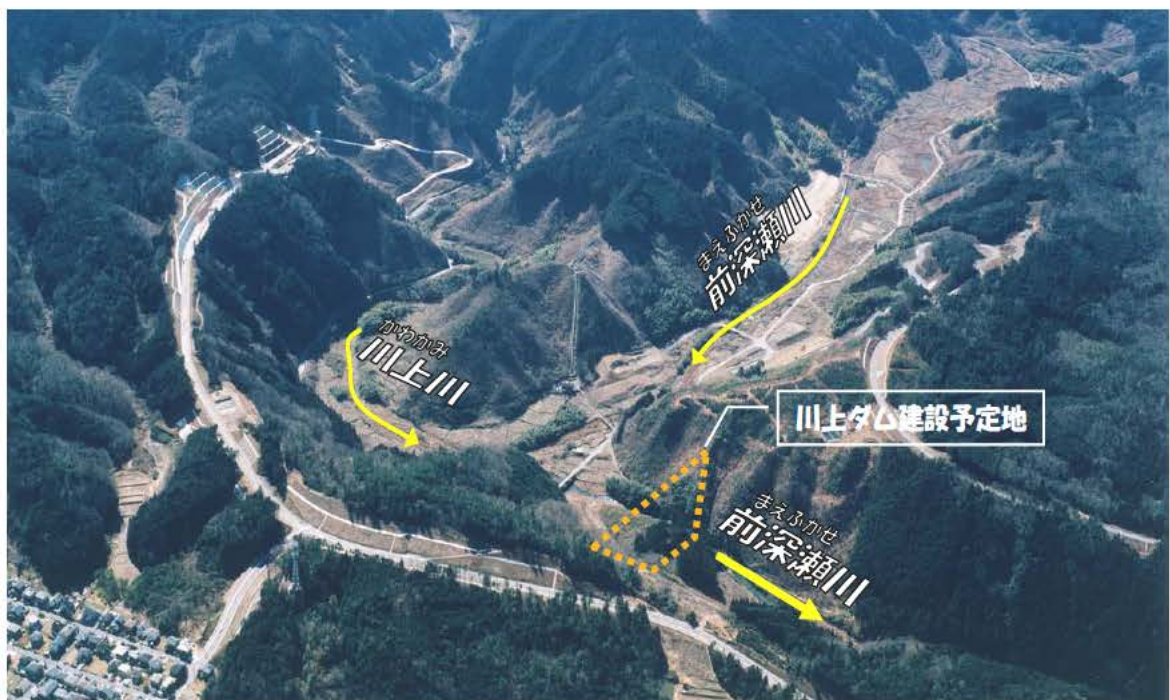
写真 6. 3. 1 川上ダム建設予定地の状況
