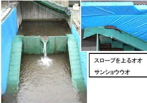
図 7.3.4 オオサンショウウオ道（スロープ式）の試験状況（C区画）
