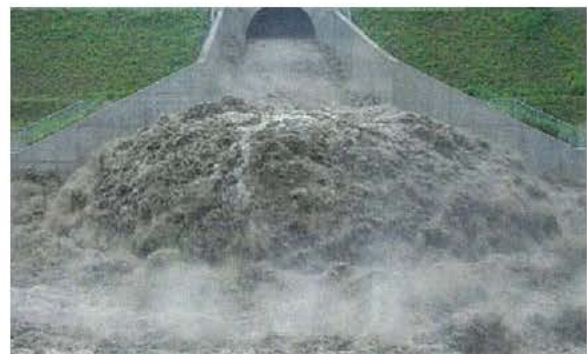
写真 5.1.5 バイパス吐口の状況
