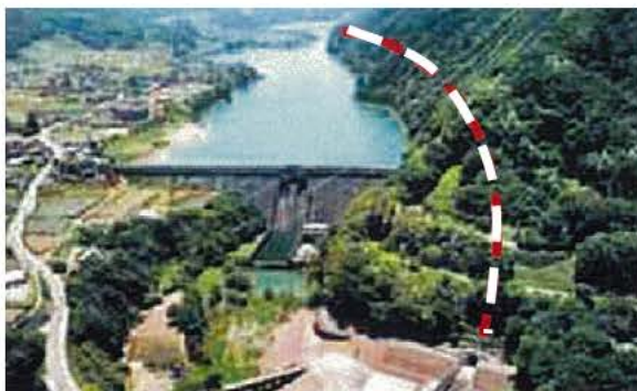
写真 5.1.4 美和ダムの土砂バイパス
