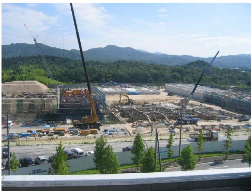
写真 4.1.1 ゆめが丘浄水場の工事状況（H19年8月撮影）
