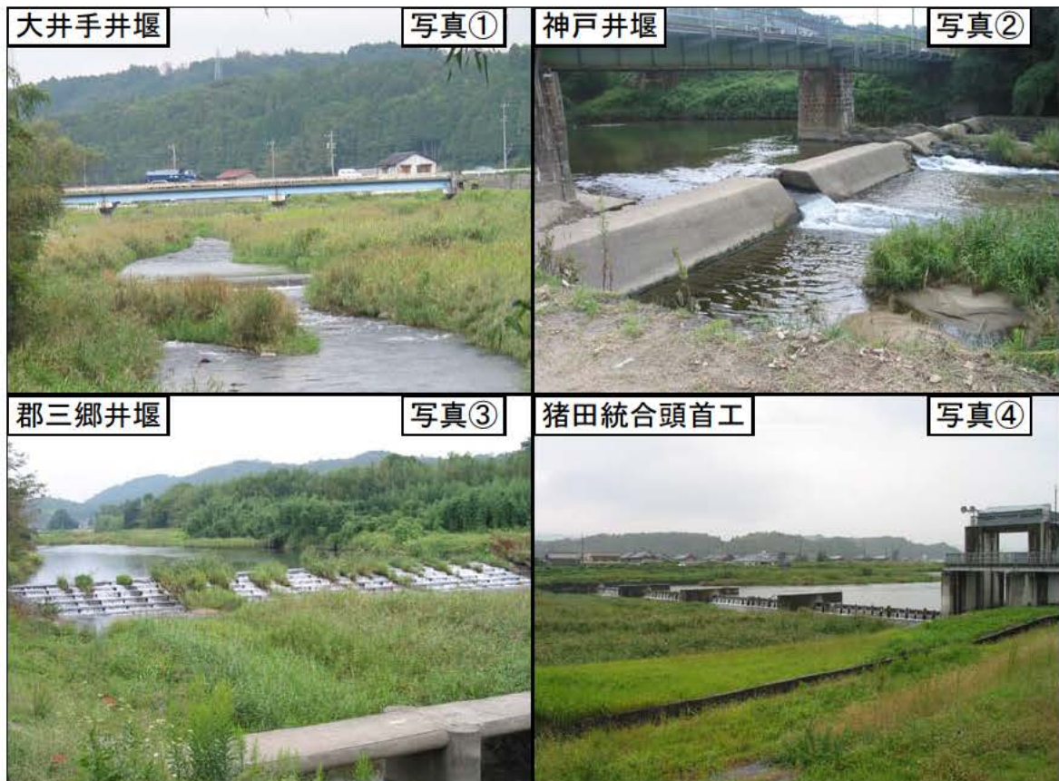
写真 4.2.1 主な井堰の状況
