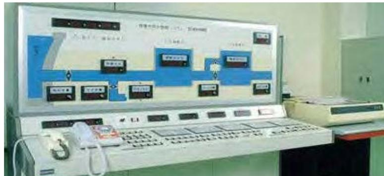
写真 4.2.4 青蓮寺用水管理システム監視制御盤
