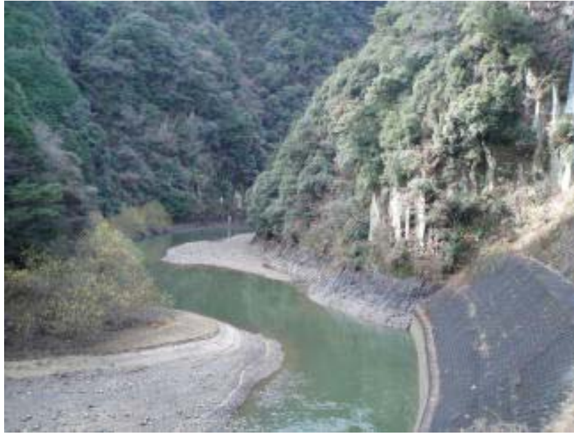
写真 5.5.1 青蓮寺ダム貯水池流入端堆砂状況
