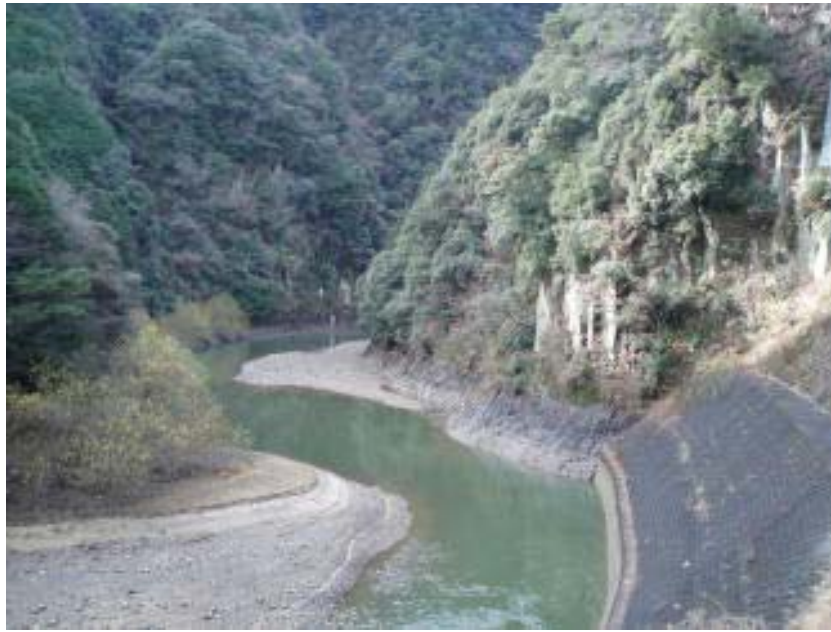
写真 5.5.1 青蓮寺ダム貯水池流入端堆砂状況
