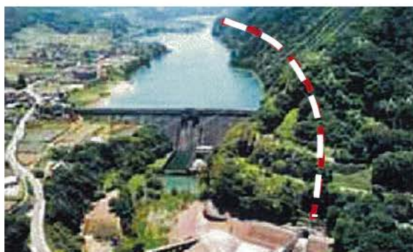
写真 5.1.4 美和ダムの土砂バイパス
