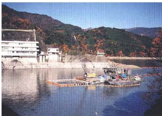
写真 5.1.2 浚渫(井川ダム)
