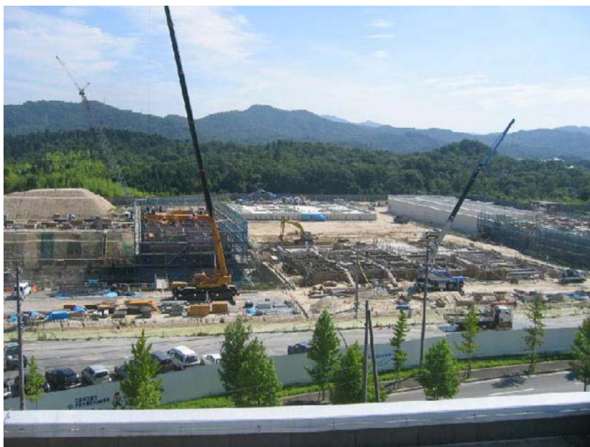
写真 4.1.1 ゆめが丘浄水場の工事状況（H19年8月撮影）
