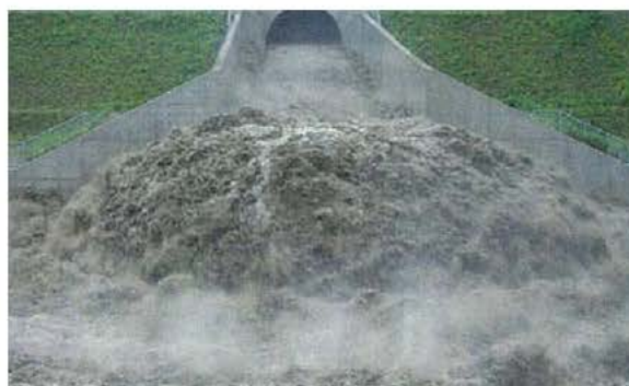
写真 5.1.5 バイパス吐口の状況
