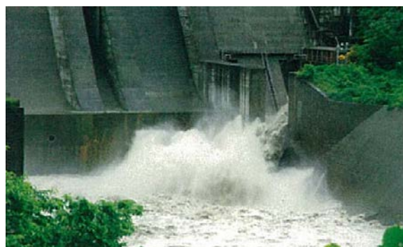
写真 5.1.7 排砂ゲートからの土砂フラッシュ状況
