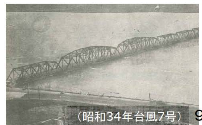
洪水が橋桁にぶつかっている枚方大橋
