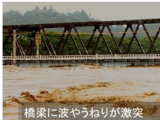
複数の橋梁で洪水が流れにくくなり水位が上昇(平成16年福井市:足羽川)
