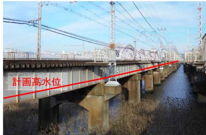
阪急神戸線淀川橋梁
