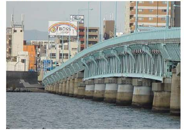
堤防に食い込む 国道2号淀川大橋
