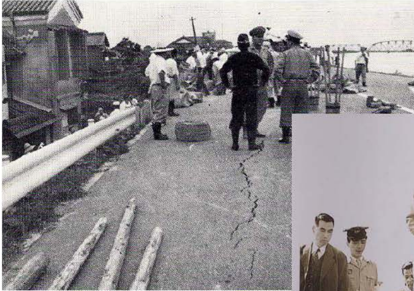
昭和34年8月台風7号出水 枚方かぎや裏の天端亀裂
