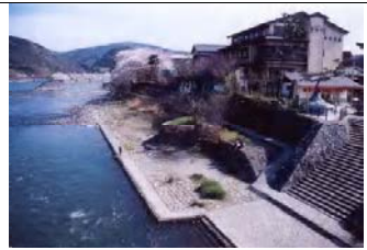
⑬ 大きく河道を狭められた川。2つの水制は壊され、砂洲は消滅。
