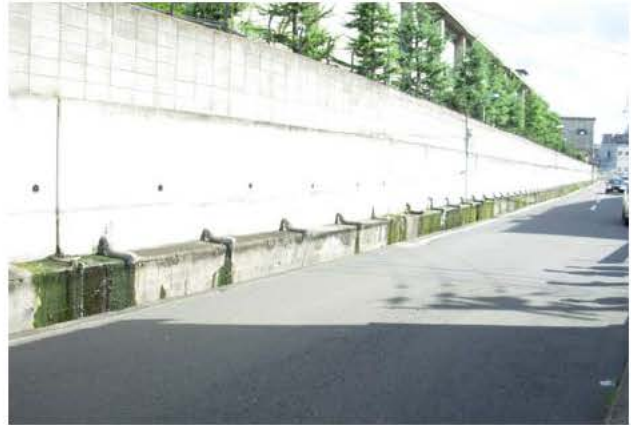
ユニチカ宇治工場西側で自噴する地下水
