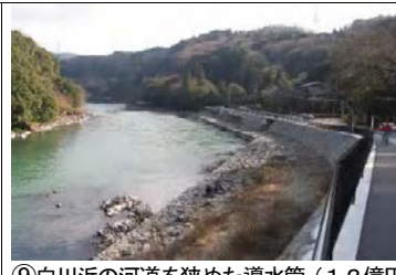
⑧ 1500\text{m}^3/\text{s} 改修（河床掘削）を行えば、水位低下（約 1\text{m} ）で1300年の歴史を持つ亀石は陸地化し、歴史的景観は破壊される。
