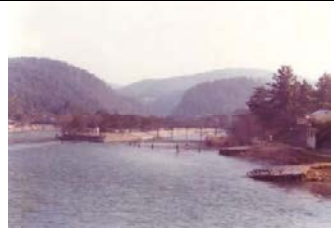
⑭ 工事前の左岸。2つの水制があり、砂洲がある。
