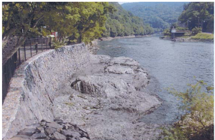
フォトモンタージュ 河道掘削時 [本川約0.4m河道掘削]
