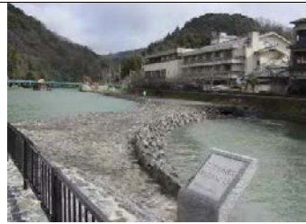
⑩ 塔の川締切堤（2億円）。鵜飼船は本川に出られず。導水管からの毎秒 3\text{m}^3/\text{s} の流入水では塔の川の環境が悪化、藻の異常繁殖と悪臭。喜撰橋からの景観も悪化。流下能力低下。
