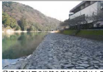
⑩ 塔の川締切堤（2億円）。鵜飼船は本川に出られず。導水管からの毎秒 3\text{m}^3/\text{s} の流入水では塔の川の環境が悪化、藻の異常繁殖と悪臭。喜撰橋からの景観も悪化。流下能力低下。
