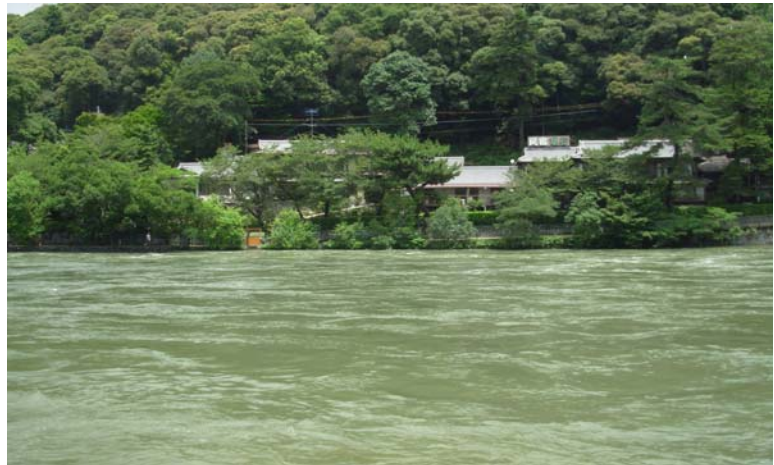
天ヶ瀬ダム 840\text{ m}^3/\text{s} 放流時の塔の島河道の状況
