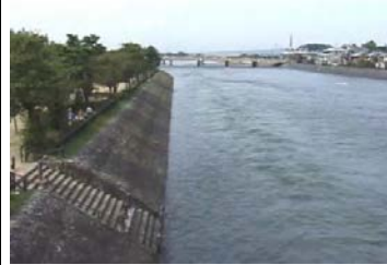
④ 掘削後の橋島。急斜面の護岸をつくったために2件の転落・死亡事故が発生。流心が護岸のすぐそばを流れる危険な状態。
