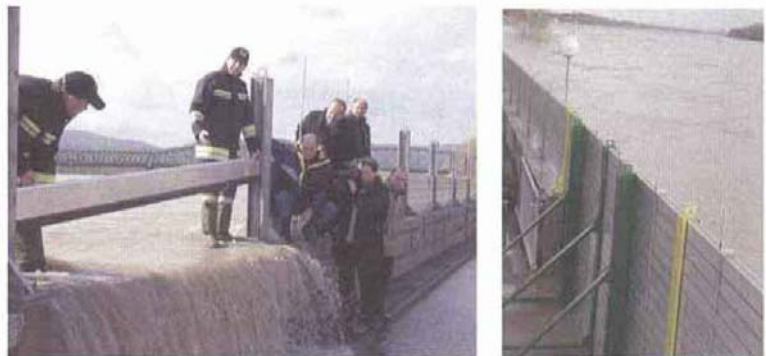
ドノウ川の可搬式仮設堤防（河川環境管理財団資料より）
