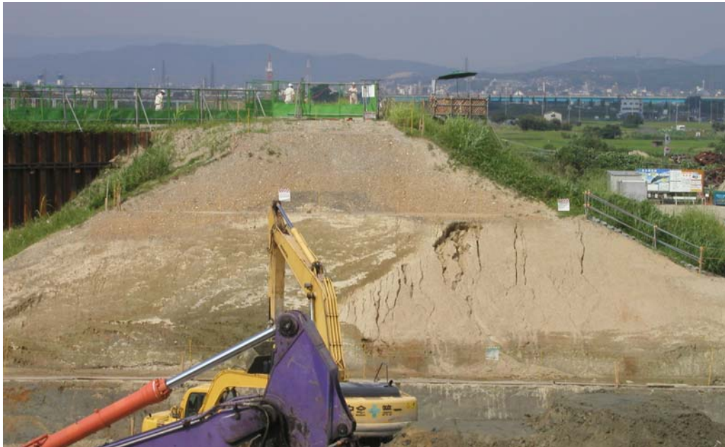
巨椋池排水機場付近の堤防開削状況の写真
