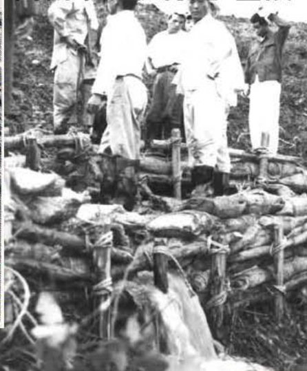
昭和34年9月伊勢湾台風 高槻市上牧付近・釜段工
