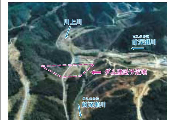
川上ダム建設予定地 （平成15年3月撮影）
