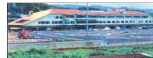
ピロティ建築 (猪名川町・太陽猪名川自動車学校)
