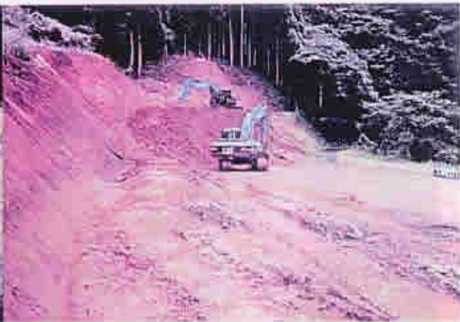
ダムサイト付近
