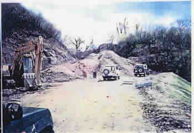
中腹より奥へ道路工事中
