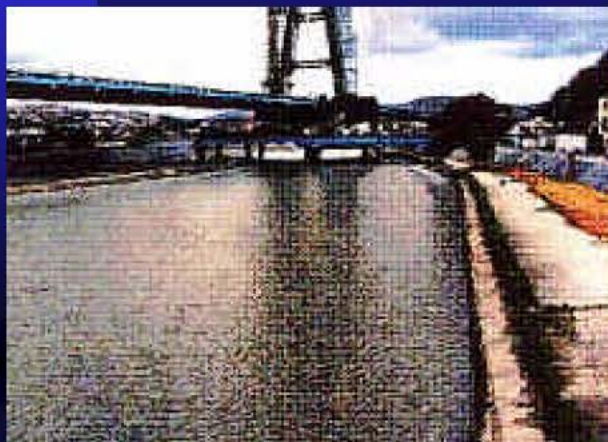
工事実施前(上流側から撮影)
