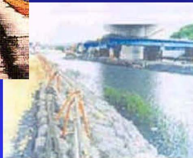
工事後(1998.4:下流側から撮影)
