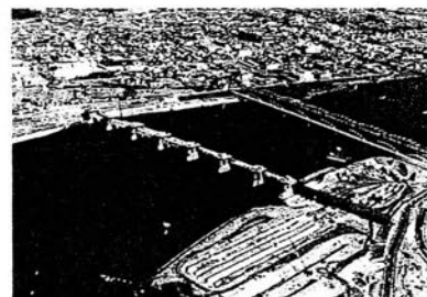
紀の川大堰(建設中)
