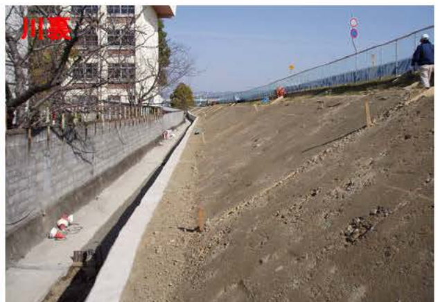
↑ 工事中(ドレーン工設置後の覆土の様子)
