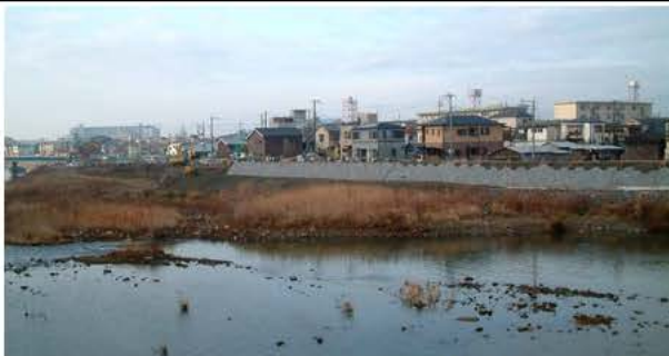
↑築堤工事の様子
