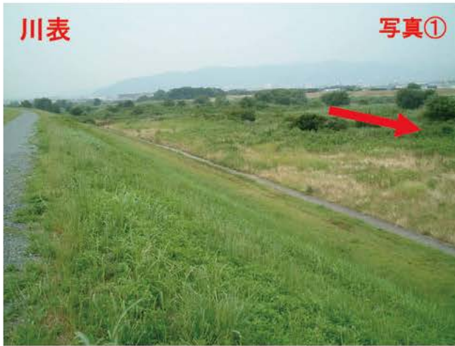
↑ 侵食対策箇所の様子(6.4K付近から上流を望む)
