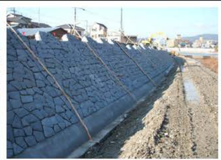
↑高水護岸工設置の様子)
