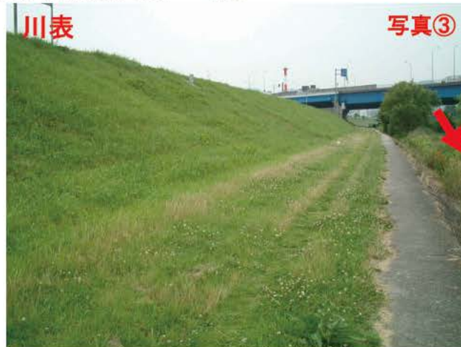
↑ 侵食対策箇所の様子(8.8K付近から上流を望む)
