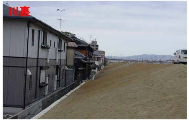
↑ 施工後(ドレーン工設置後の様子)
