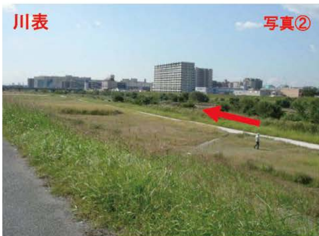
↑ 侵食対策箇所の様子(6.8K付近から下流を望む)
