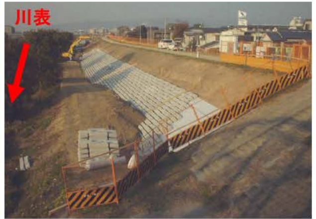
↑ 工事中(護岸工設置の様子)
