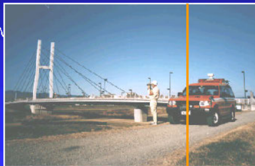
河川巡視の状況
