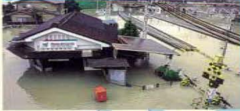
名鉄線・西枇杷島駅付近の浸水状況
