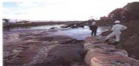
決壊箇所では懸命の復旧工事が行われた
