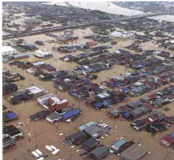
【上】新川の決壊で、隣り間に一面泥海と化した西枇杷島町 【左】約100mにわたって決壊した新川左岸堤防
